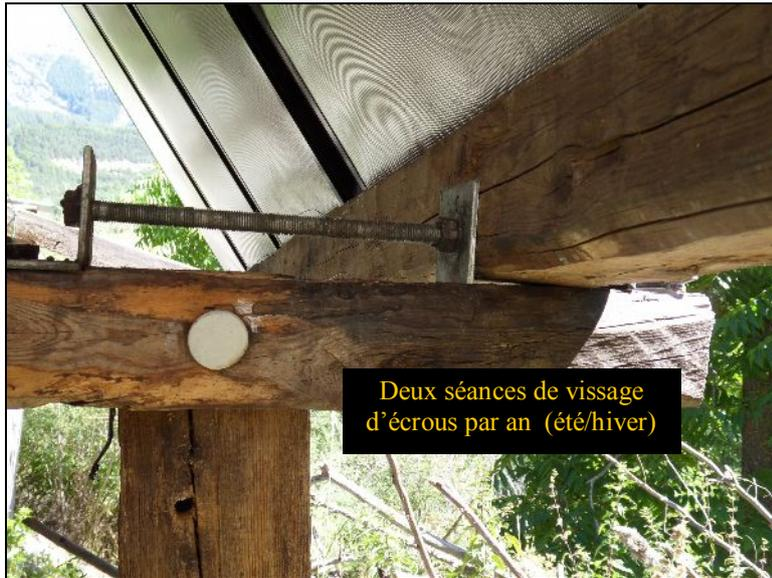
L'ajustement saisonnier de l'inclinaison élève de 2 à 3 degrés la température du stock (en partie haute : 55 à 60° par temps clair).
