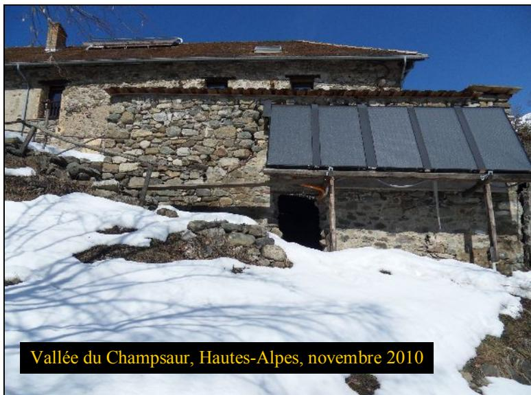
Aujourd'hui, 3 systèmes de chauffage séparés pour 95 m<sup>2</sup> d'habitation (dans une vieille bâtisse à 1240m d'altitude, 1 niveau enterré au nord, peu d'isolation et beaucoup d'inertie).
